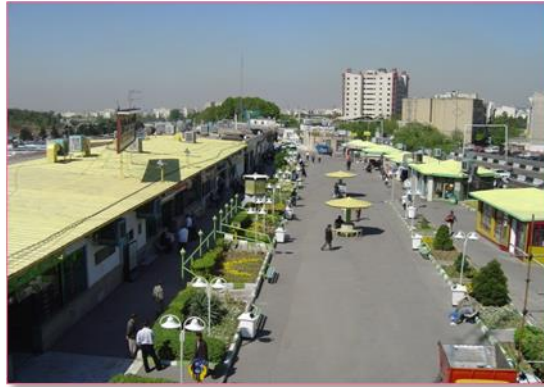
شکل شماره ۲: پایانه شرق
